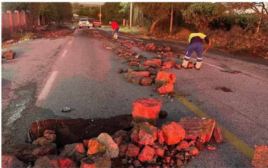
Ruptura de ducto en la presa El Realito dejó inundaciones en Tierra Nueva, SLP
