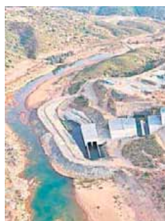
Presa de Alcolea.
